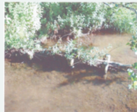
Einbau von Buhnen
