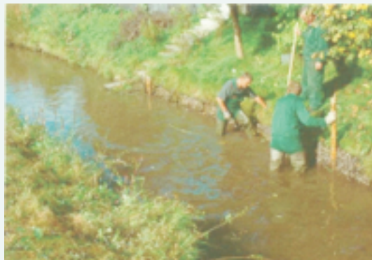
Einbringen einer Weidenfaschine
